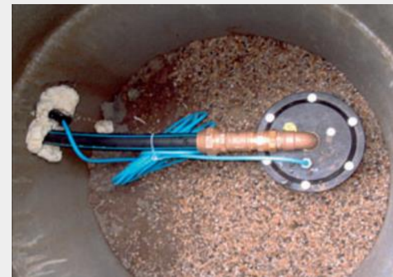
Foto: bundesverband Geothermie / Tracto-Technik
